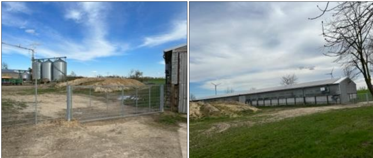
Abb. 4 neue Hochsilos direkt nördlich des GB (li.); Bestandsgebäude mit WKA (Blick nach Süden)
